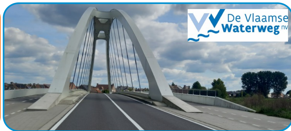
Bouw nieuwe 'Munkenbrug' met afgescheiden voet- en fietspad op brug, Ooigem - Desselgem.
