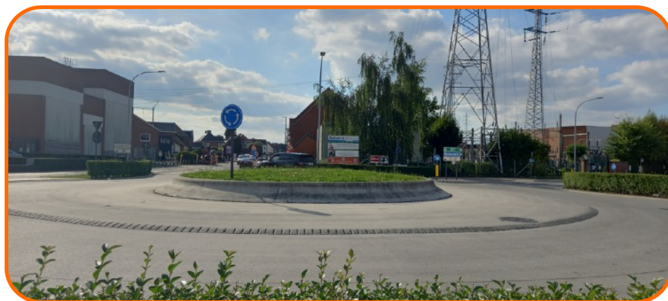
Aanleg van rotonde op het kruispunt Wakkensteenweg - Rijksweg, Sint-Baafs-Vijve.
