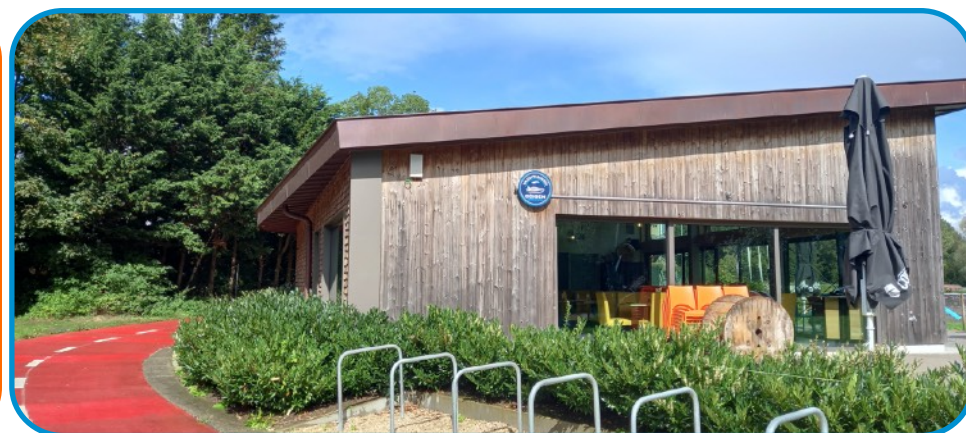
Bouw van een clubhuis aan de jachthaven van Ooigem, een cafetaria als stopplaats voor de vele recreanten langs de Leie.
