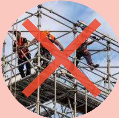
MONTAGE ET DÉMONTAGE D'ÉCHAFAUDAGES
