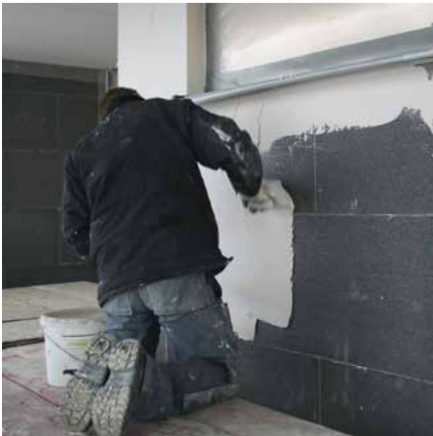
Aanbrengen van de uitvlakkingsmortel
